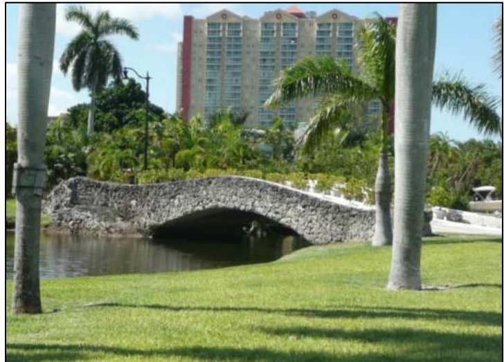
Photo 5-16. Sunny Isle Bridge #2, Miami-Dade County (No. 874218)
